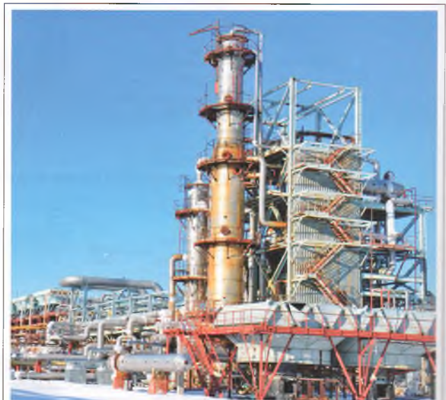
Рис. 7. Установка низкотемпературной конденсации
